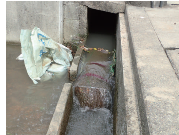
図 3. 水路に設置した罫の様子
