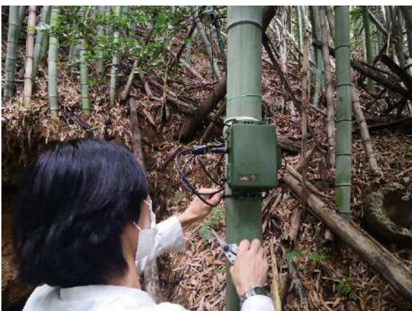
自動録音装置の設置（才井戸流）
